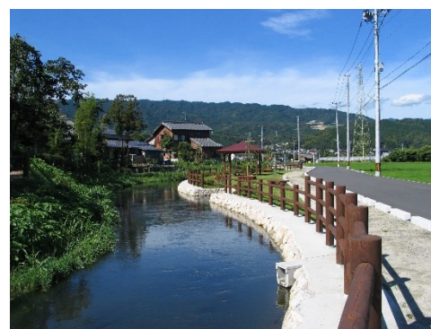
図2-14：現在の裂田溝の状況
