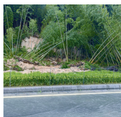
▲根ごとスライドして斜面崩壊した竹林
