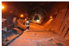
笹子トンネル天井板落下事故 (2012)
