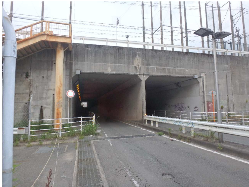
図-1 管理大型カルバート（7061 道善・中原線ボックスカルバート）
