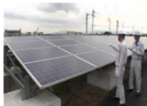
太陽光パネルの外観検査
