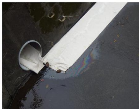
・油が流出したためオイルフェンスを設置し、被害の拡大を防いでいる様子
