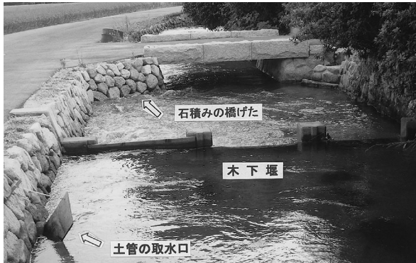
取水口-③ 木下堰
