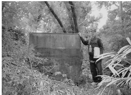
まつのき せ と 松木瀬戸にあるサイフォン式水路用の枡 現在、九州新幹線工事のため現地には行けません。
