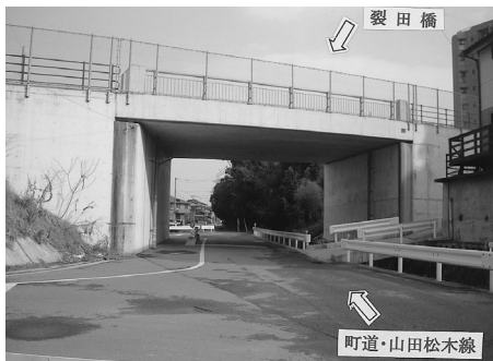
さくたはし 裂田橋 平成18年10月3日開通
