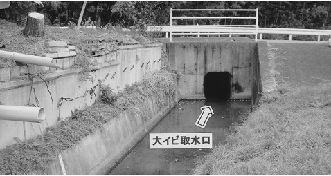
大イビ (取水口—⑯) 大イビからの取水は、途中何本かに分かれながら仲区の田んぼを巡ります。巻き上げ式の取水口は、細かく記された目盛りをもとに灌漑期の配水調整を堰守さんが判断し、下流域への配慮をしています。
