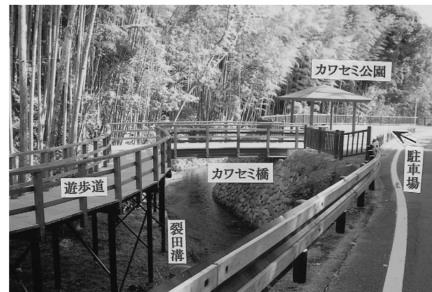
カワセミ橋 長さ10.57m 幅2.3m 高さ1.1m
