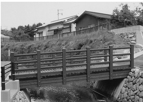
しもごしょばし 下御所橋 長さ6.38m 幅3.67m 高さ1.2m
