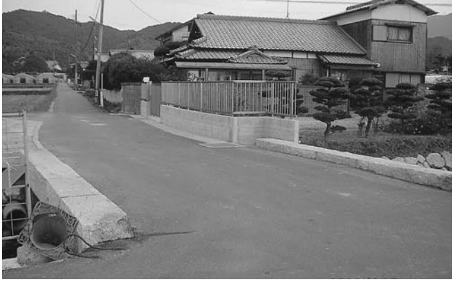
新設された橋／新しい橋の名前が考えられています
