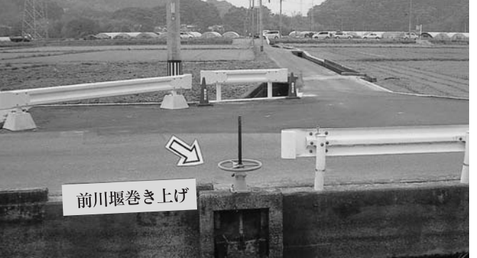
取水口⑦前川堰巻き上げ
