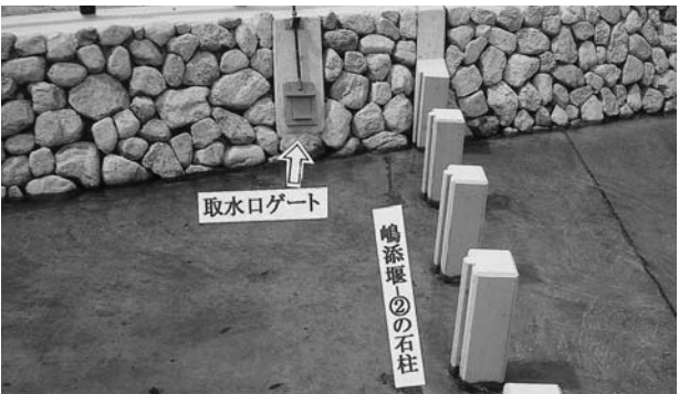
「嶋添堰②」の石柱と取水口ゲート 石柱の上流側の両脇にある切り欠きに板を渡して仕切りをし、上流側の水位を上げ、取水口ゲートを開いて北側の田んぼへ送水します
