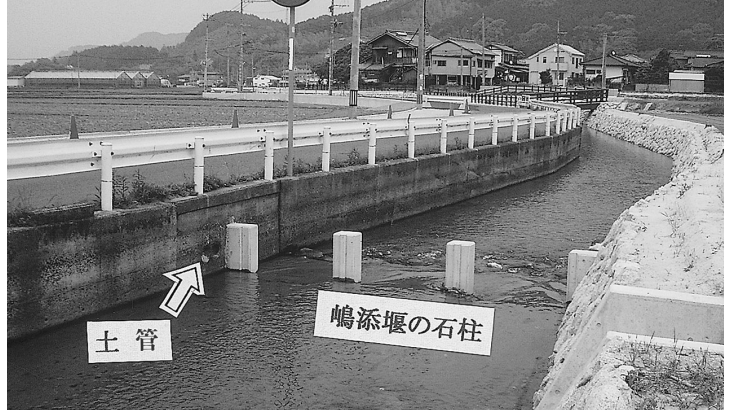
取水口-4 (嶋添堰①) 土管から道路下をくぐり、北側の田んぼへ送水されます
