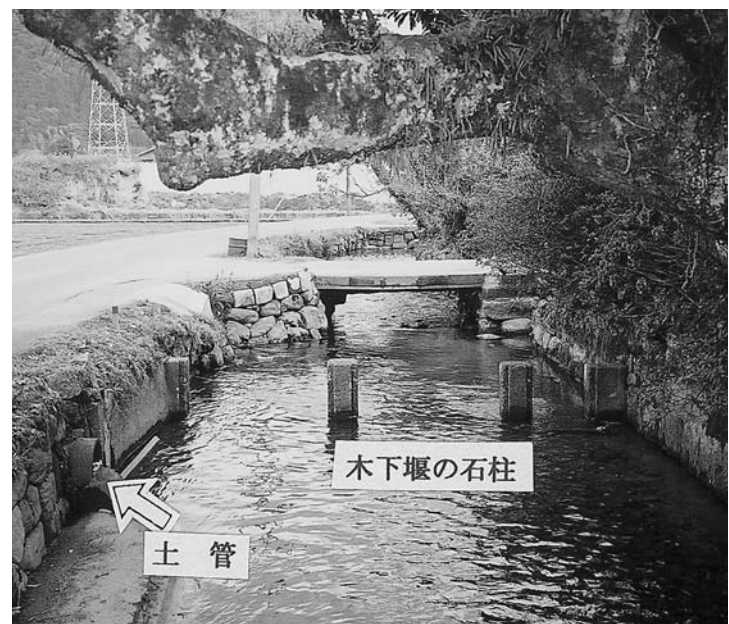
取水口-③ 木下堰の石柱 水の流れが少ないときには、堰の仕組みを見ることができます
