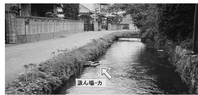
「疏水百選」に選ばれた裂田溝の小柳地区の風景 疏水百選とは、農林水産省が日本の美しく豊かな「水、土、里」を育て維持していくことを目的に、全国から優れた百の農業用水路を選出したものです。
