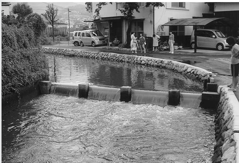
工事完了後の西中溝堰付近
