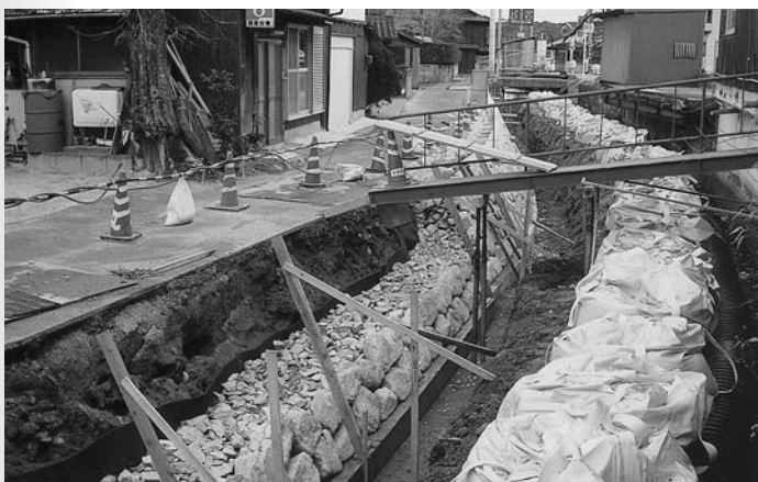
水環境整備事業第一期工事で改修中の西中溝下流。護岸をコンクリートで固めない「ラップストーン工法」により、両岸の石垣は魚たちの絶好のすみかになります。
