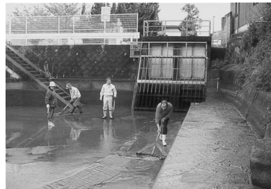
裂田溝水門前の清掃
