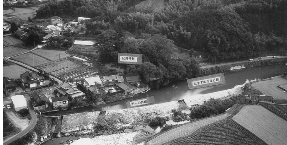
改築前の一の井堰（昭和62年）
