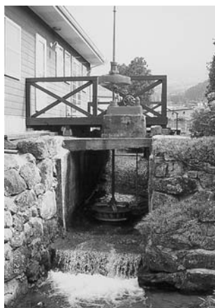
結城家に残る (水力タービン)跡
