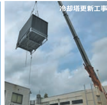
冷却塔更新工事
