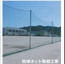
防球ネット取替工事
