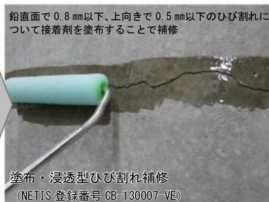
図-4 補修の新工法
