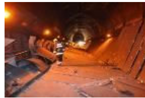
笹子トンネル天井板落下事故 (2012)
