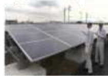
太陽光パネルの外観検査
