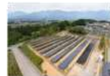
リユース品を使用した発電所
