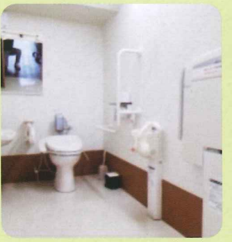
多機能トイレの設置
