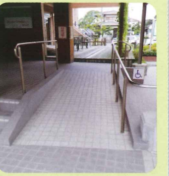
スロープの設置
