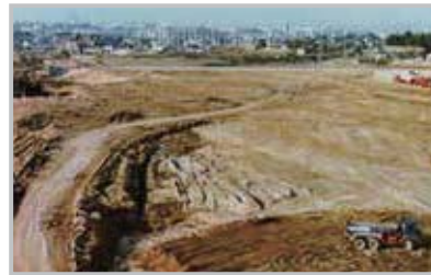
昭和49年1月 土地区画整理事業工事着手
