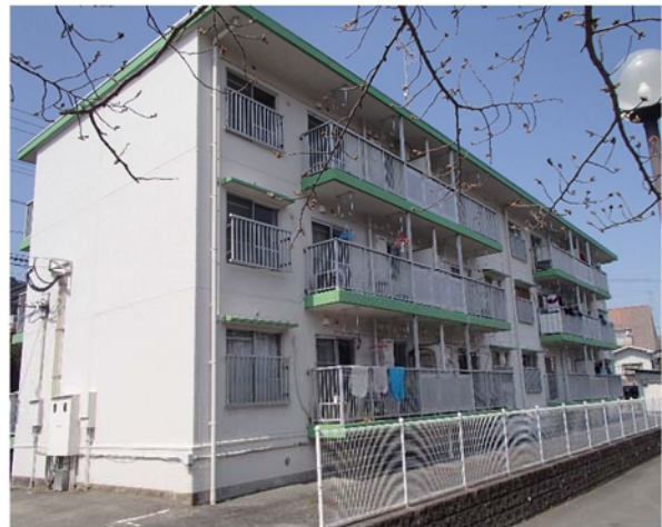
中層耐火構造3階建（ベランダ側）
